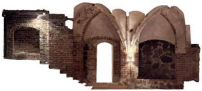
Joonis 1. Ajaloolise ehitise objekti laserskaneerimispunktide pilve väljavõte koos fotografeeritud värvviandmetega, Turun linnan herrainkellari, üks Turu muuseumikeskuse ruumidest. Joonis: Tietoa Finland Oy.
