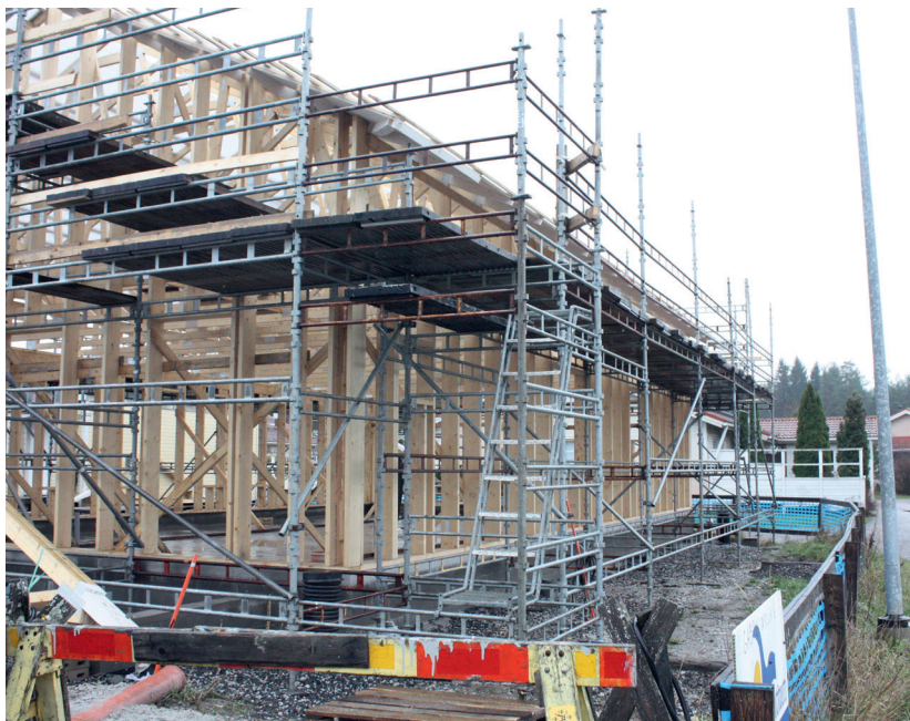
Karkassi ehitamine ühepereelamu ehitusplatsil
