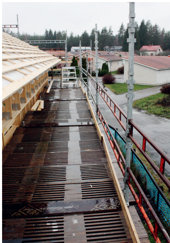
Tööohutuse hindamise käigus vaadeldakse näiteks tellinguid ja piirdeid.
