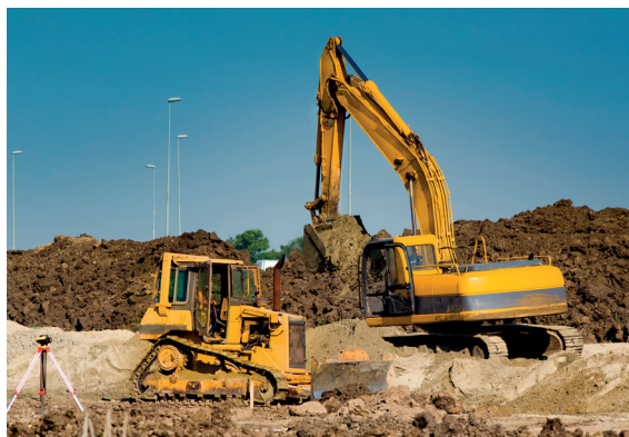
Roomikmasinad töötamas. Buldooser lükkab pinnast. Ekskavaator keskendub vaid pinnase kaevamisele, mitte tasandamisele.
