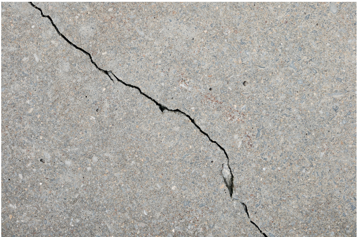
Praad betooni pinnal
