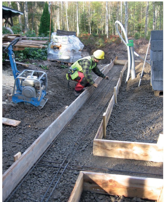
Raketisekilpidest saab teha kiiresti pikki raketisi.
