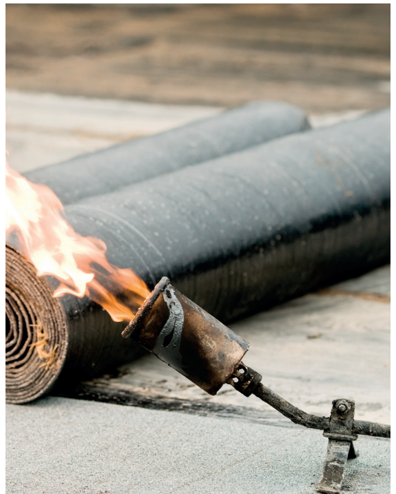
Bituumenrullmaterjal ja leegiga põleti. Materjal on rullides ja nende ühenduskohas tuleb alati teha ülekate. Bituumenrullmaterjali ei paigaldata kunagi kokku ots otsaga.
