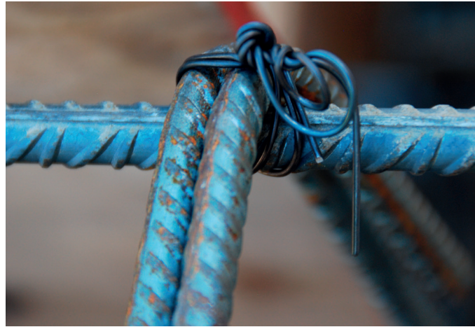
Armatuurvarraste sidumistraat peab taluma kogu valamise ajal tekkivat koormust.
