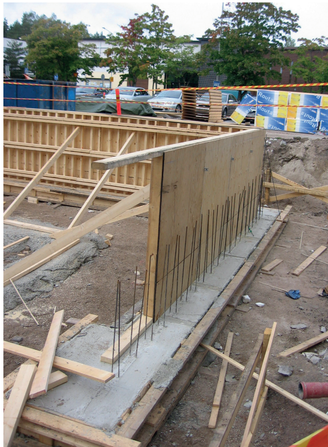
Taldmiku peale tehtud plaatpinnaga raketis. Plaadipinna taga on tihe toetus.
