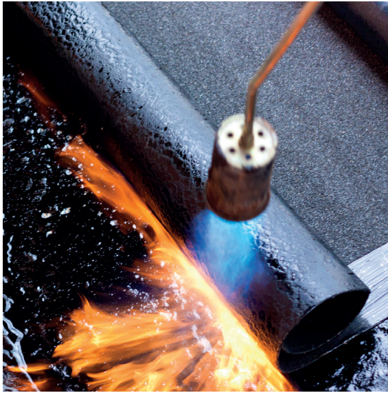
Rullmaterjali kinnitamine leegi abil nakkepinnale
