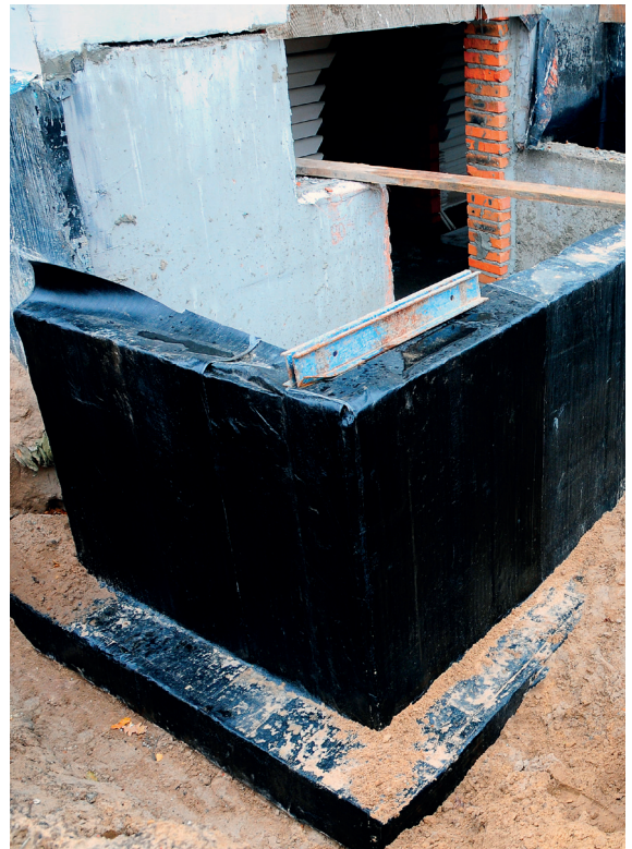
Vundamendi valmis isolatsioon.
