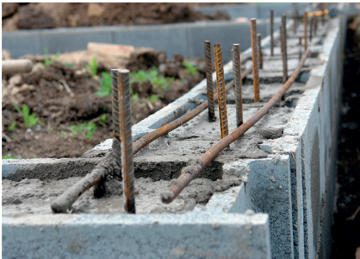
Betoonplokide siseosad on täidetud betooniga.
