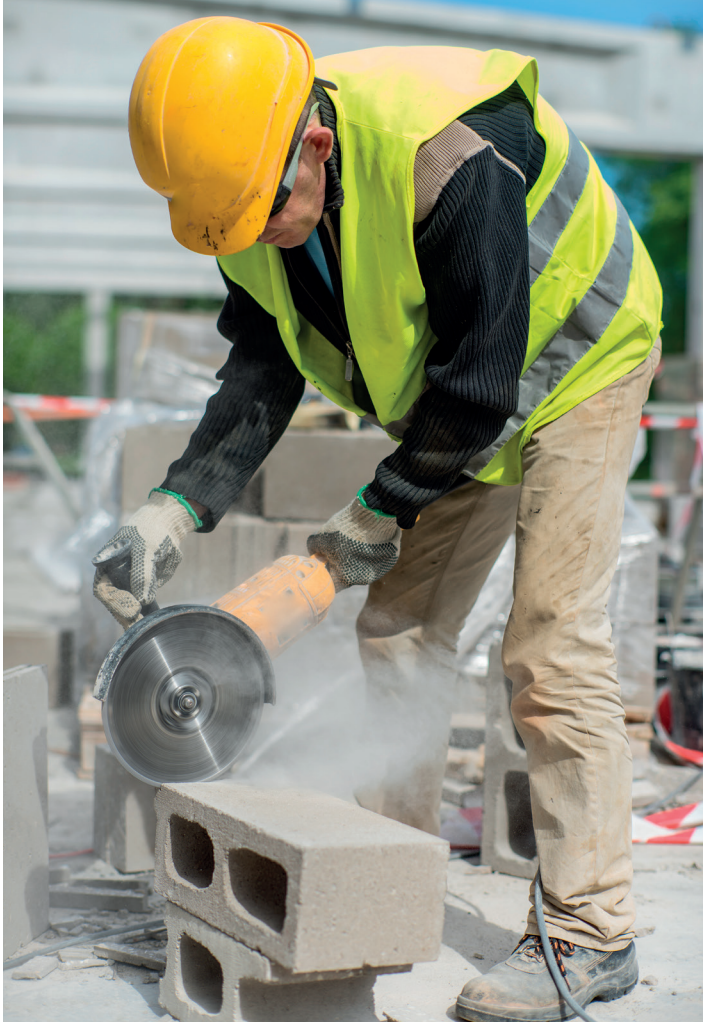
Ploki lõikamine ketaslõikuriga
