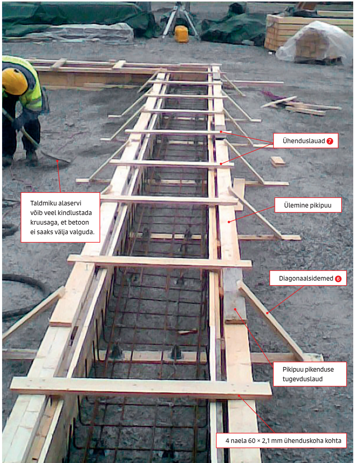
Raketise laudis toestatakse diagonaalsidemetega 6 ja peale tulevate ühenduslaudadega 7.
