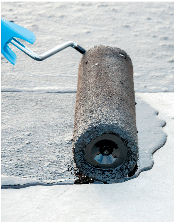
Bituumenlahuse pealekandmine rulliga
