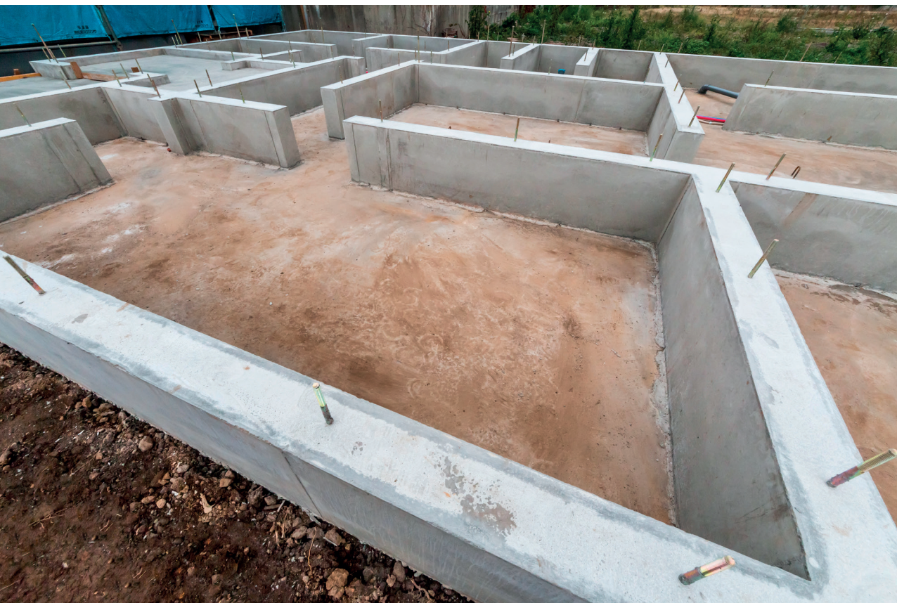
Raketise abil saadud betoonpind
